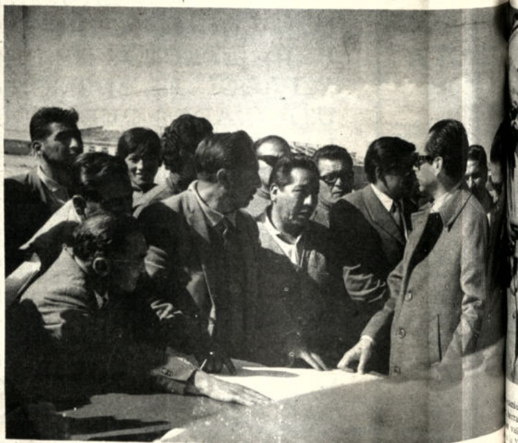
-CONAVI entregó terrenos al Sindicato Mixto de "Transportes Rápidos", los mismos que servirán para la construcción de una moderna terminal de autobuses.
