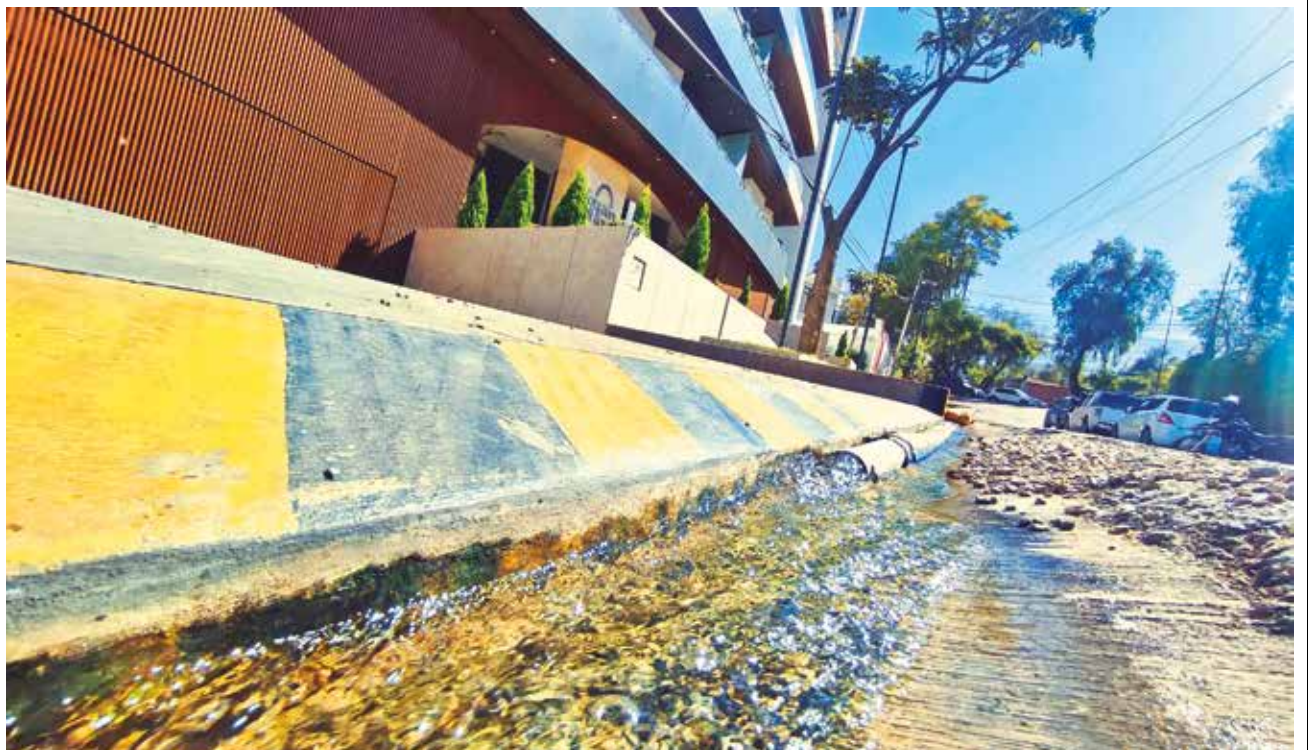
El agua subterránea que se acumula en algunos edificios, en la zona norte de la ciudad de Cochabamba. FOTOS DANIEL JAMES
