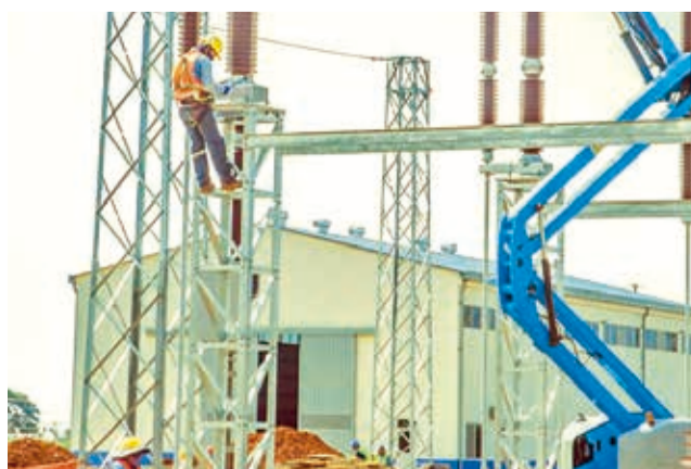
El tendido de la nueva línea de extra alta tensión. ENDE
