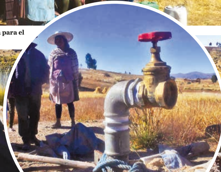
El pozo que no funciona por falta de luz.
