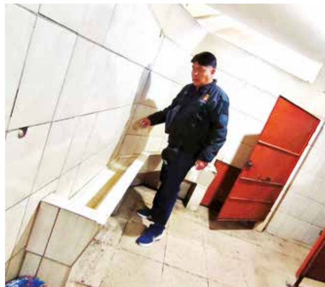
Control de infraestructura y agua en los baños.
