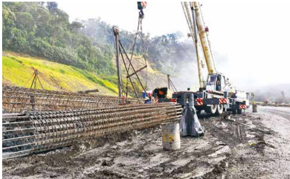
Obremos de Sinohydro trabajan en la doble vía El Sillar, el miércoles. DANIEL JAMES
