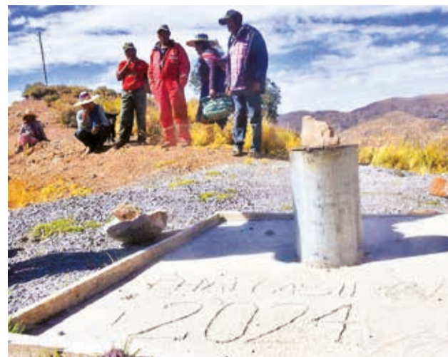
El pozo perforado en Challacirca que no funciona por falta de bomba y energía eléctrica.
