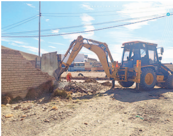
Construcción fue demolida con maquinaria pesada /GAMO
