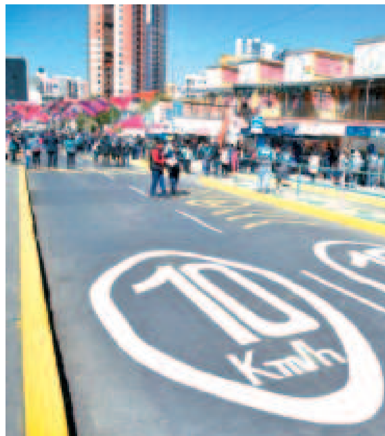
El arreglo de parte de una acera y vía en Miraflores.
