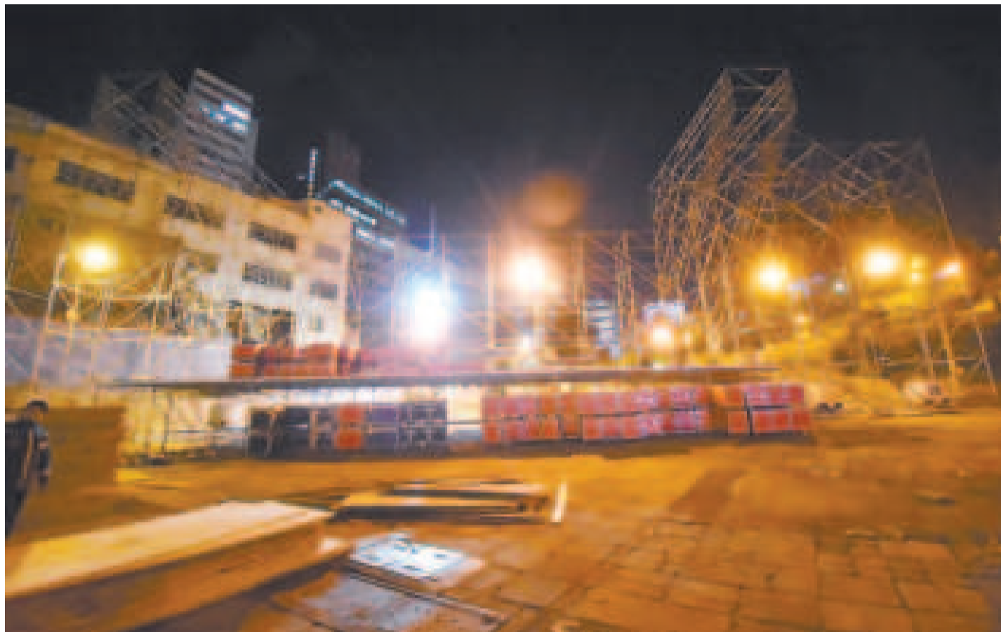
La tarima para la verbena paceña ya está en construcción.
