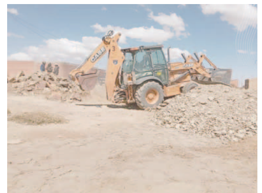
Retiro de material de construcción de la Urbanización La Prensa /GAMO
