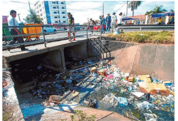
La acumulación de plásticos es uno de los problemas que afecta el drenaje de la ciudad. También daña el paisaje urbano
