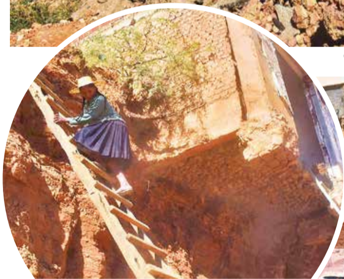
Suben a sus casas con escaleras por los hundimientos.
