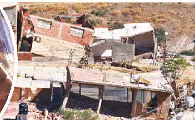
El barrio devastado por los deslizamientos.
