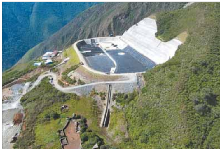
MIGUILLAS. Impermeabilización de la cámara de carga Umopalca.
