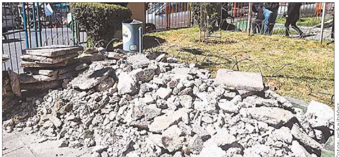
CENTRO. Así luce la plaza Eguino, donde los obreros de la Alcaldía realizaban trabajos de refacción.
