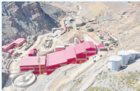
Infraestructura de la nueva planta de Colquiri /CORTESÍA
