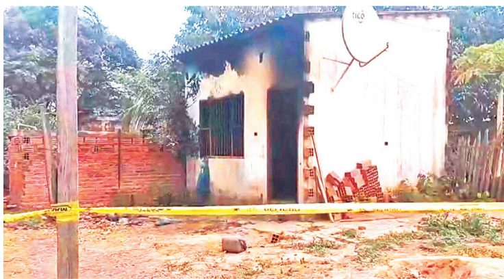
Esta es la vivienda donde ocurrió el incendio en San Julián
