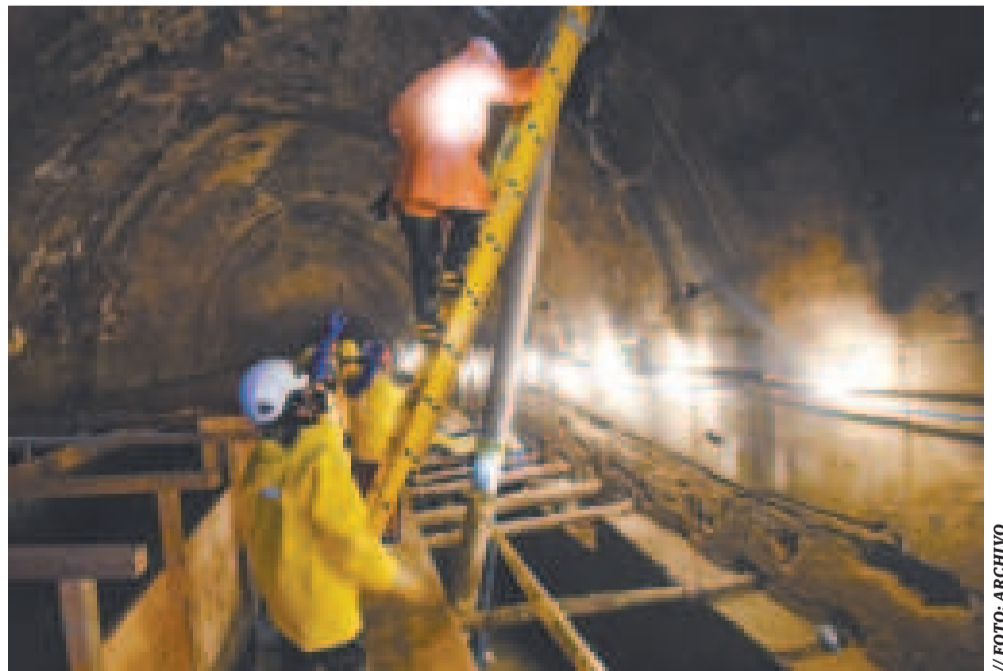
Operarios en el tramo 2 del embovedado del río Choqueyapu.
