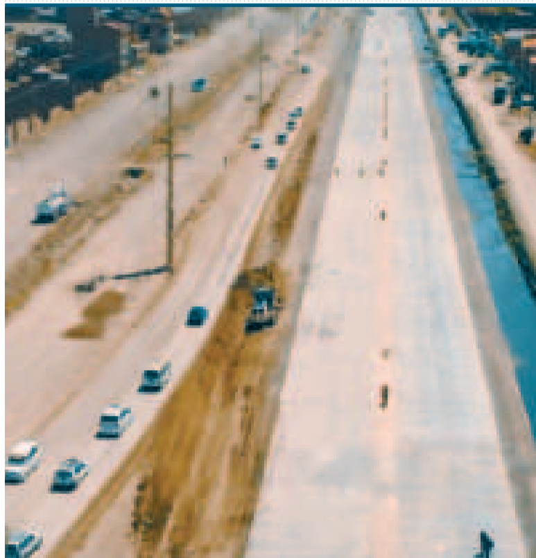
El área de intervención para la construcción de los puentes.
