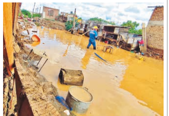
Una vivienda afectada por las inundaciones. JOSÉ ROCHA
