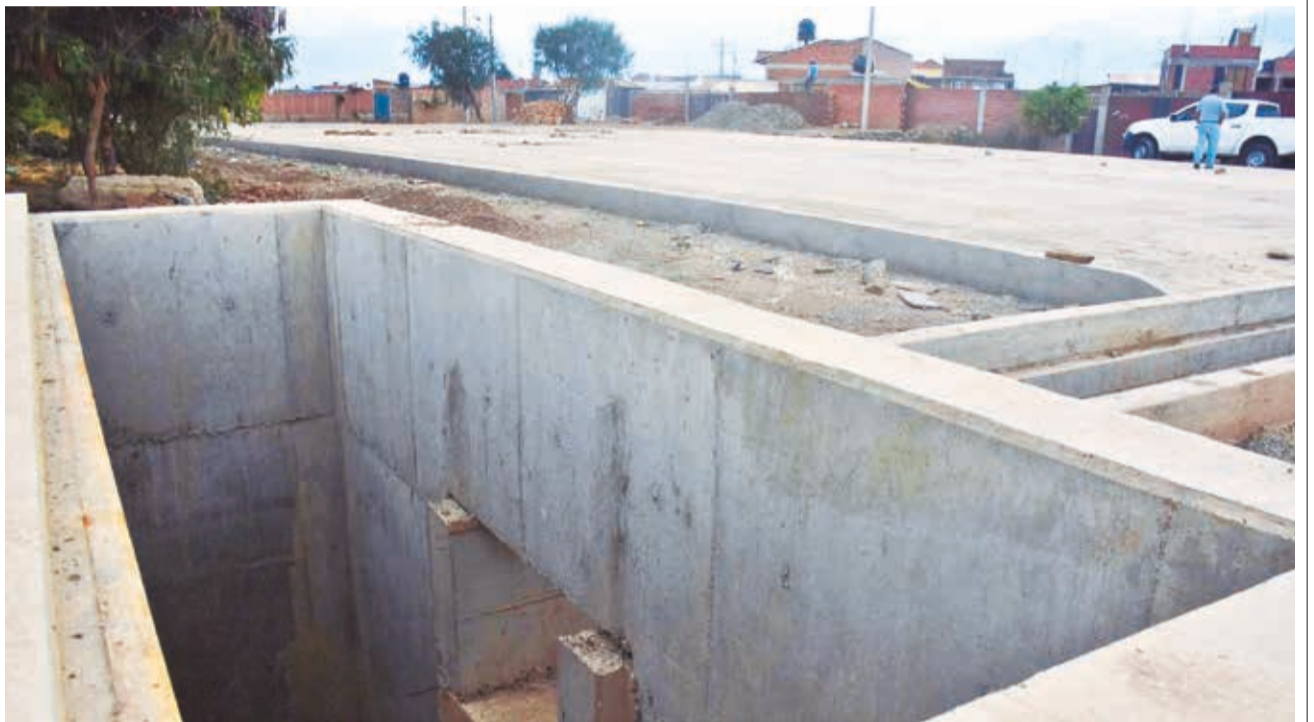
El cárcamo de bombeo de la avenida Costanera del Sur. DANIEL JAMES
