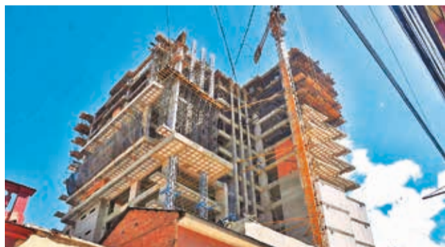
La construcción del edificio municipal. CARLOS LÓPEZ
