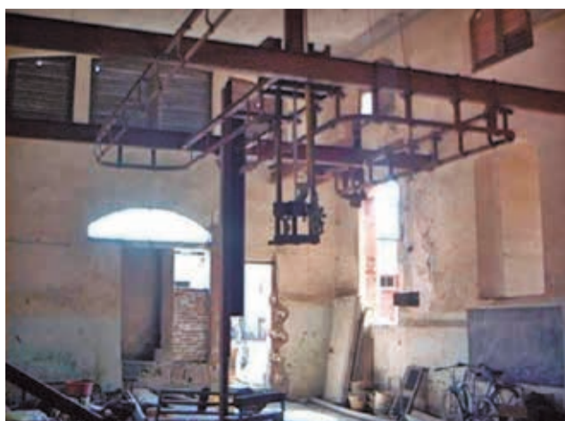
Detalles. Diversas huellas que permanecen en el lugar como testigos de su uso anterior como las rieles y vigas y rieles para el colgado de las reses. CORTESÍA
