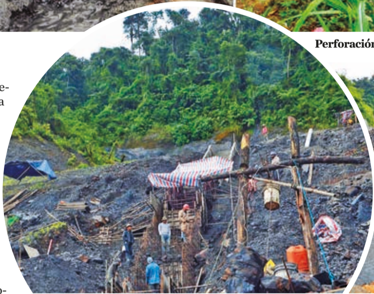
Construcción de un canal de agua en el km 103.
