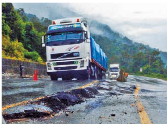
Levantamiento de la plataforma en el kilómetro 108.
