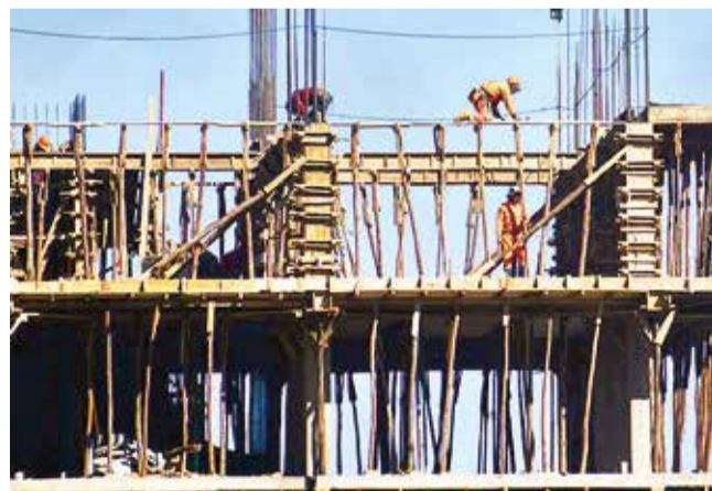
Un edificio en construcción en Cochabamba. CARLOS LÓPEZ
