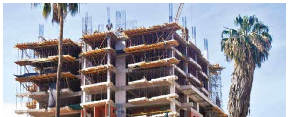
La construcción del edificio municipal, observado por la DGAC. CARLOS LÓPEZ
