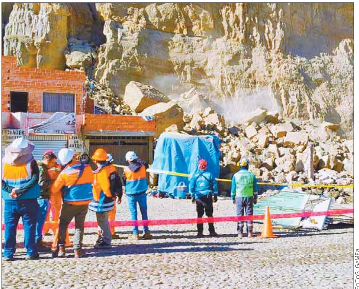
EMERGENCIA. Un talud cayó sobre parte de una vivienda de la calle 23 de Achumani y dejó cinco heridos.
