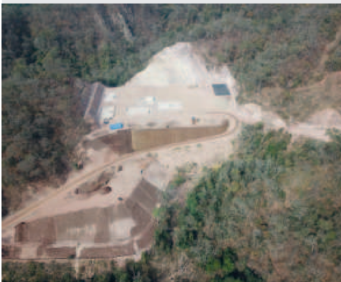
Los trabajos de camino y planchada alrededor de uno de los pozos.
