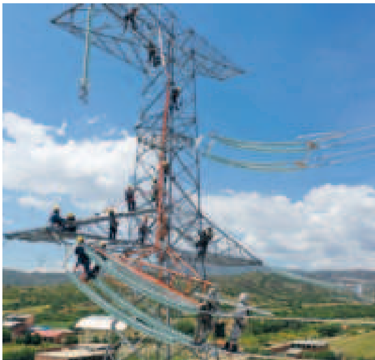
Trabajos del personal de la estatal ENDE.
