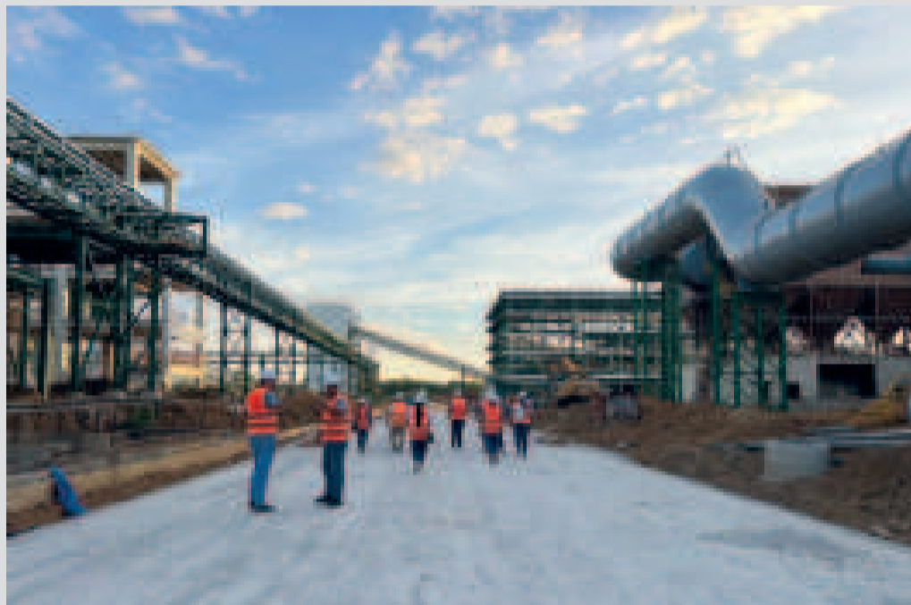
Inspección de las obras de construcción del complejo siderúrgico.
