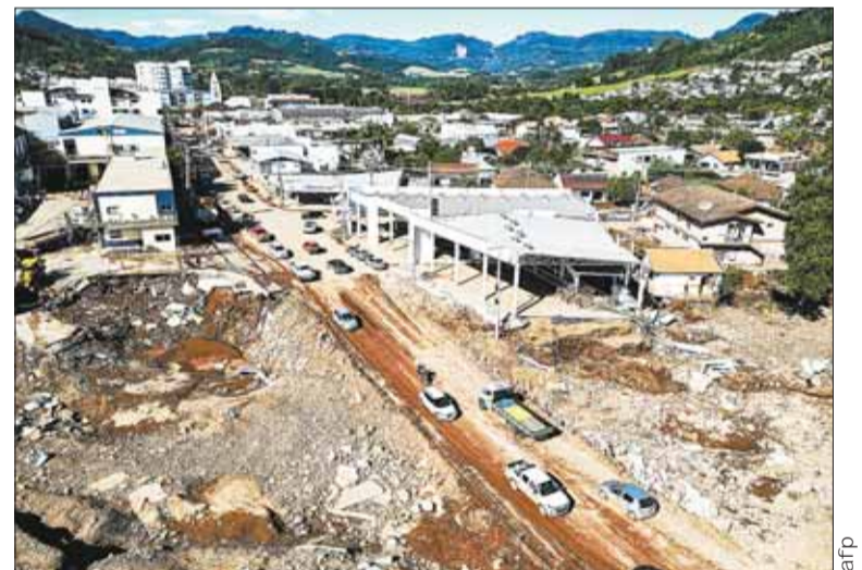
DAÑO. Nueve de cada 10 industrias sufrieron daños por las lluvias.
