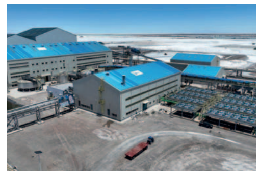
Garafulic está involucrada en los problemas encontrados en 18 piscinas evaporíticas instaladas en el Complejo de Litio en Uyuni /YLB
