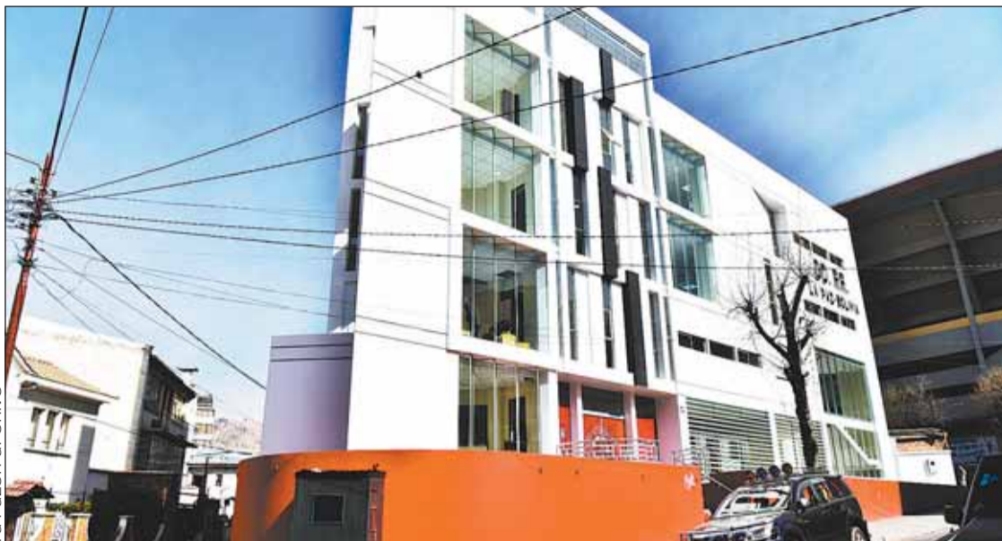
INSTALACIONES. El edificio de Derechos Reales en la ciudad de La Paz.
