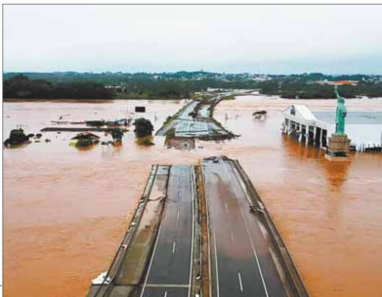
TRAGEDIA. Las aguas suben y se evacuaron a 351.000 personas.
