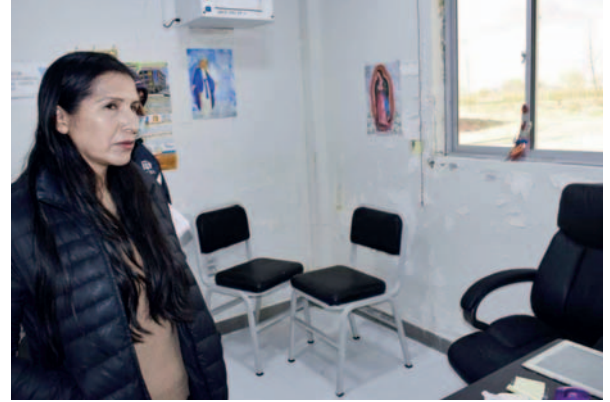
Inspección al Centro de Aislamiento revela abandono /CMO
