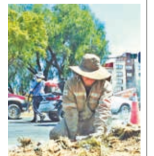
Trabajos para instalar el campamento. C. LÓPEZ
