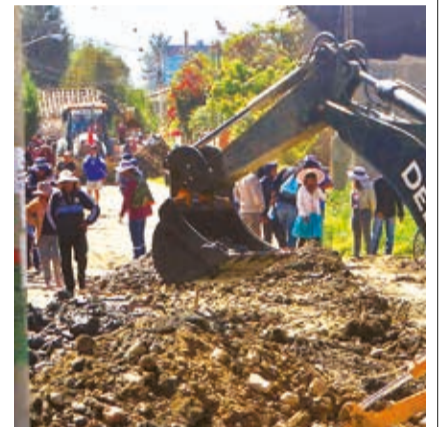
La maquinaria abre zanjas para el alcantarillado.
