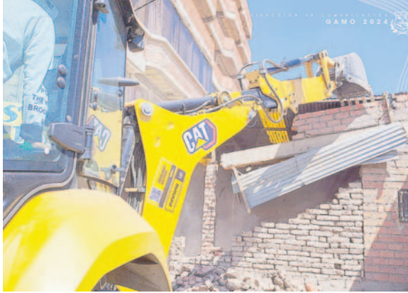
Construcción ilegal fue demolida /GAMO
