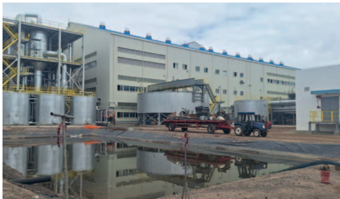
Instalación de la Planta Industrial de Carbonato de Litio en Uyuni /YLB
