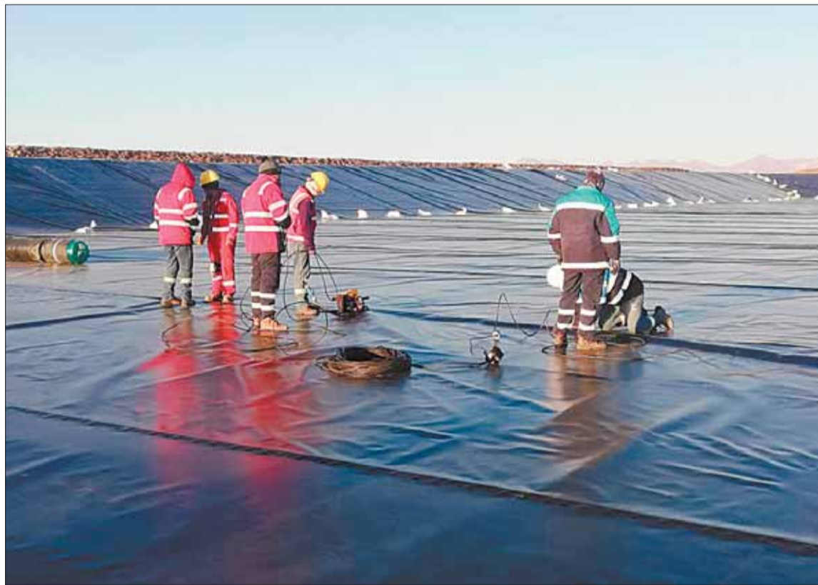
IMPERMEABILIZACIÓN. El proceso de colocado de PVC en las piscinas del salar de Uyuni, Potosí.
