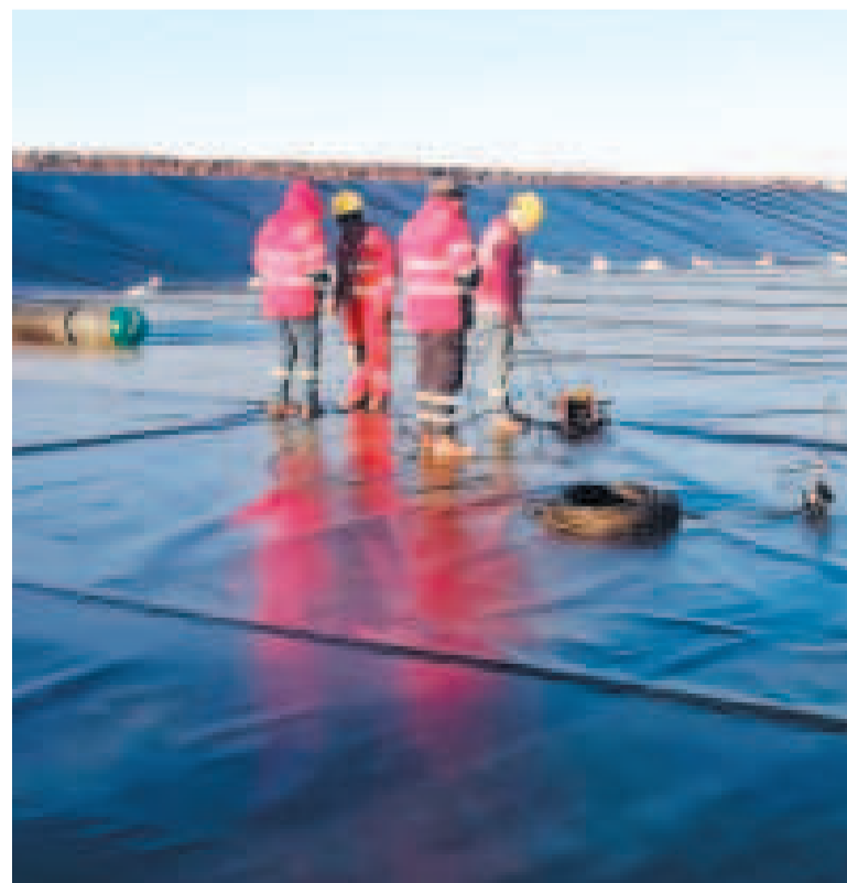
Los trabajos de reimpermeabilización y optimización de las piscinas.
