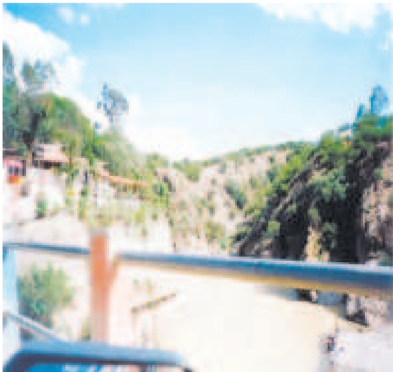
Vista desde el actual puente de Tomatitas.
