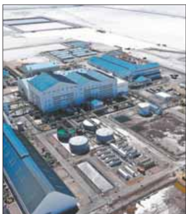
Planta de Carbonato de Litio.
