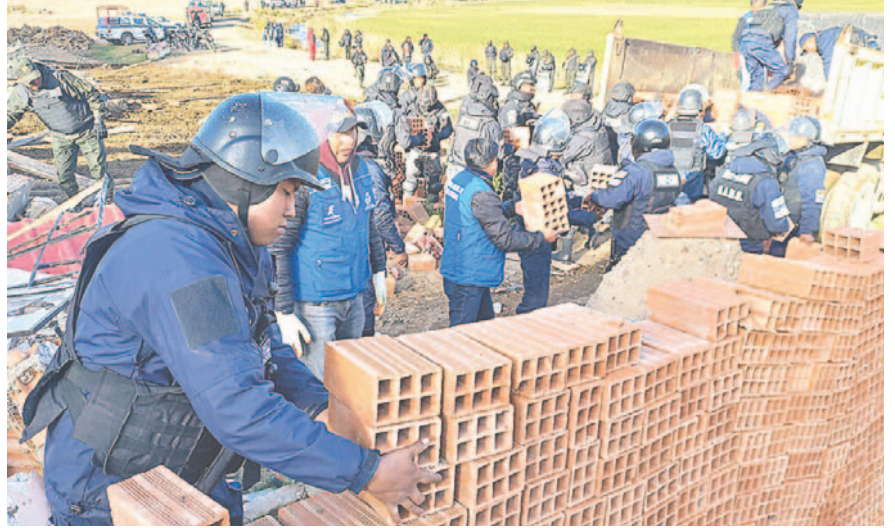
Construcción clandestina fue demolida /GAMO
