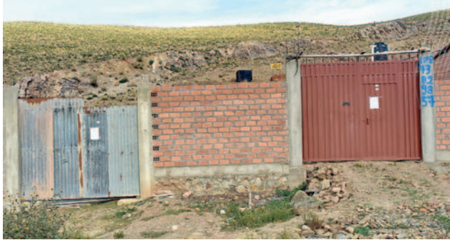
Construcciones ilegales fueron notificadas /GAMO
