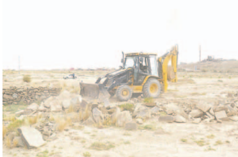
Momento en el que se hace la demolición de un cimiento ilegal / LA PATRIA
