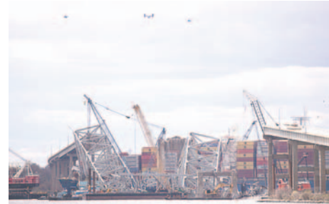
Los restos del puente Francis Scott Key, en Baltimore, Maryland, Estados Unidos, el 5 de abril de 2024 /EFE/ MICHAEL REYNOLDS
