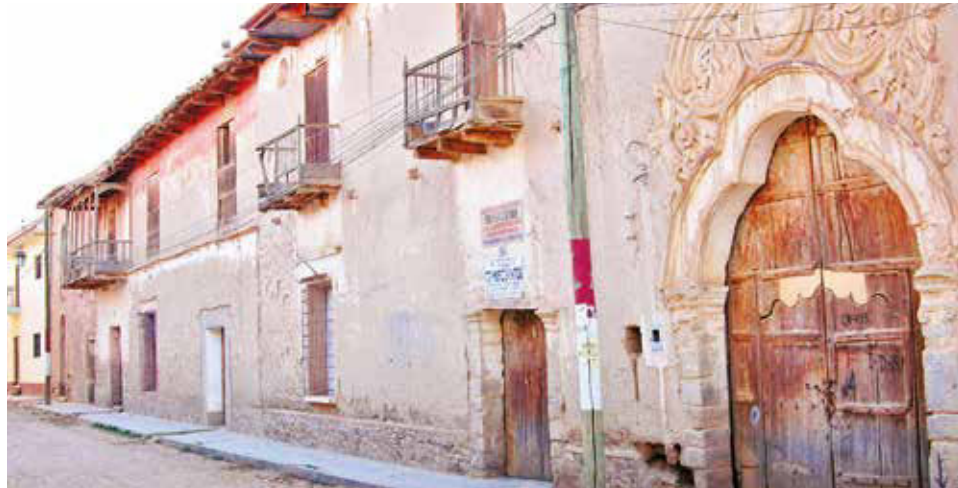
La fachada del Cuartel de Melgarejo, en Tarata, que aparece en la venta. LOS TIEMPOS
