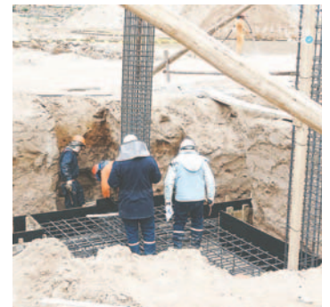
Verifican obras del proyecto hospitalario /GAMO
