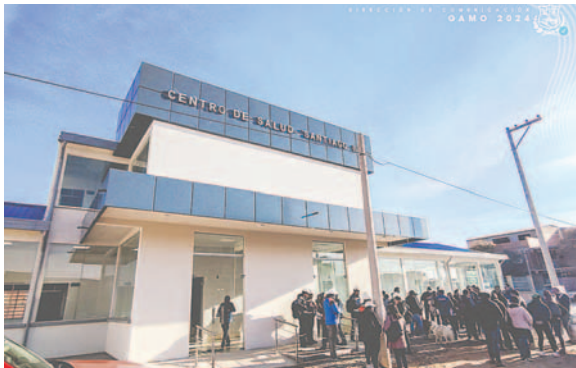
Construcción del Centro de Salud Santiago II fue concluido /GAMO
