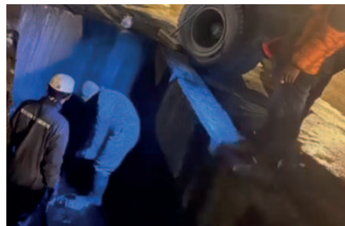
Trabajos realizados durante las primeras jornadas / EMAO
