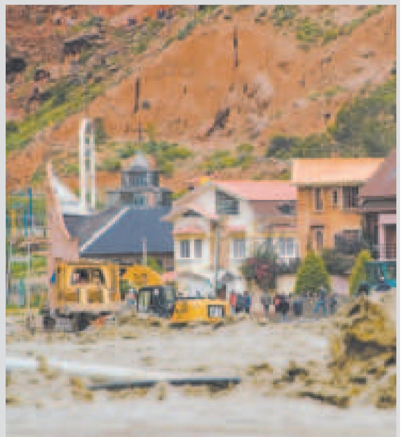
Maquinaria trabaja en Amor de Dios, uno de los barrios más afectados.
