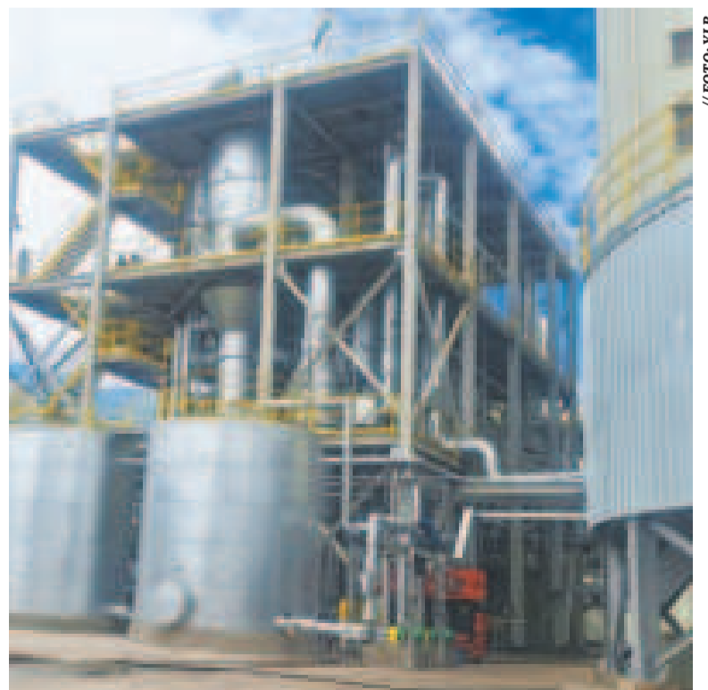
La planta de YLB.
