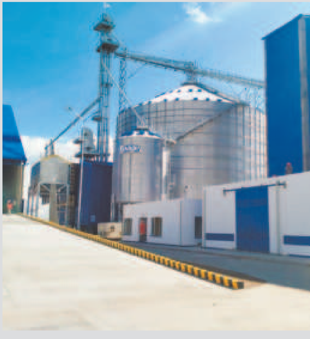
Infraestructura de la Planta Procesadora de Papa en El Alto.
