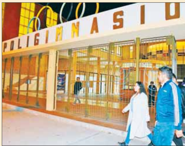
INSPECCIÓN. La ministra María Renée Castro en revisión.
