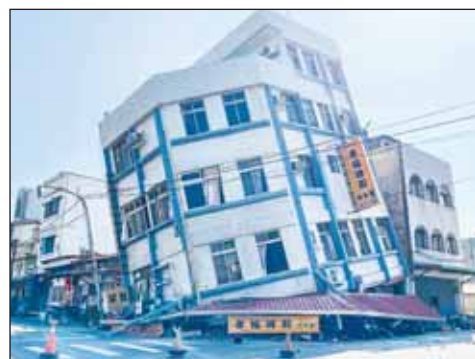
VARIOS EDIFICIOS QUEDARON INCLINADOS PERO NO SE DERRUMBARON.
