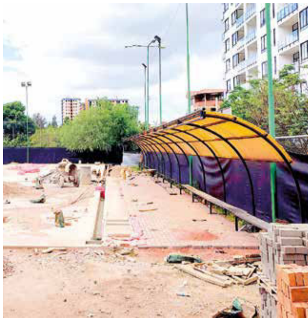
Las obras de las canchas de pádel paralizadas. DANIEL JAMES
