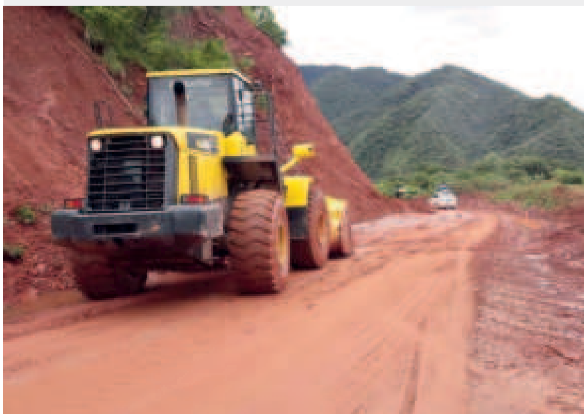
Maquinaria en la habilitación de un tramo carretero.
