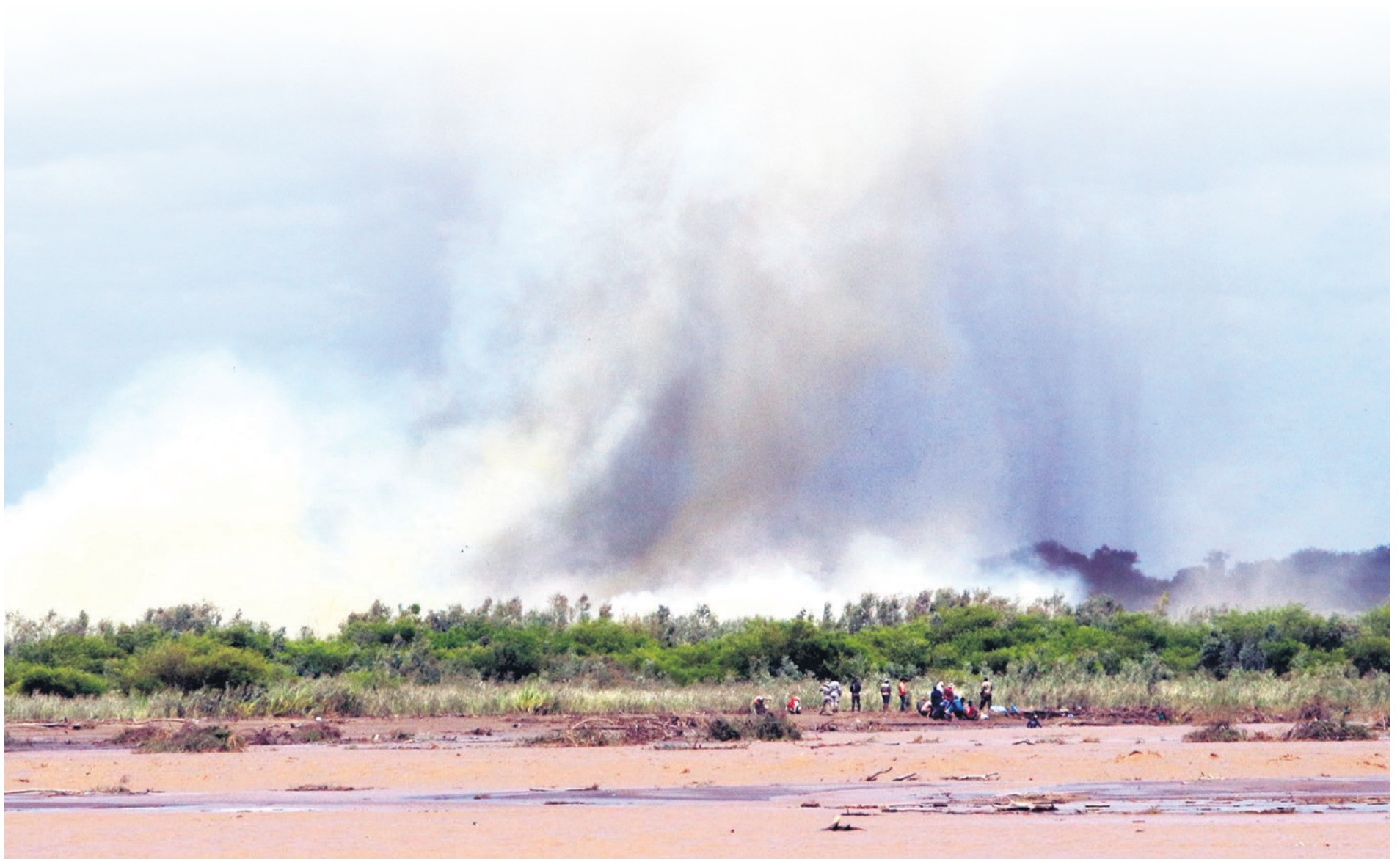
Las explosiones que se hicieron en el Río Grande, en busca de habilitar canales que eviten más rebalses, para proteger a más de 300 familias que estaban en riesgo
