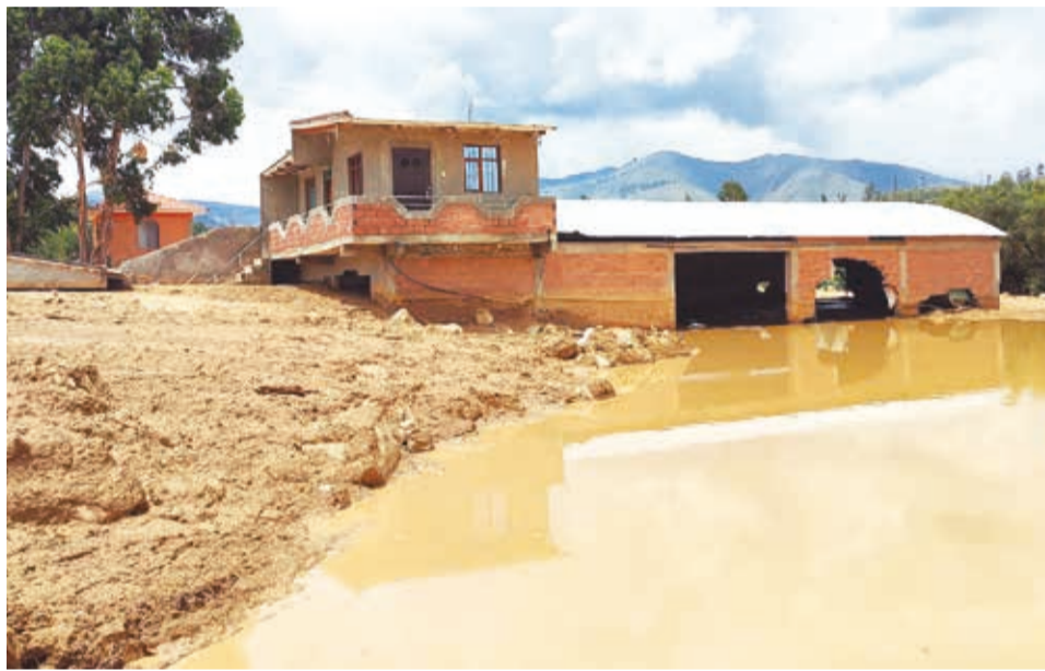
Casas afectadas por la mazamorra en la zona de Laquiña, Sacaba. DANIEL JAMES
