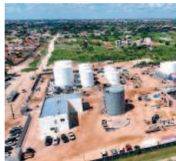
La Planta de Biodiésel I está ubicada en Santa Cruz.
