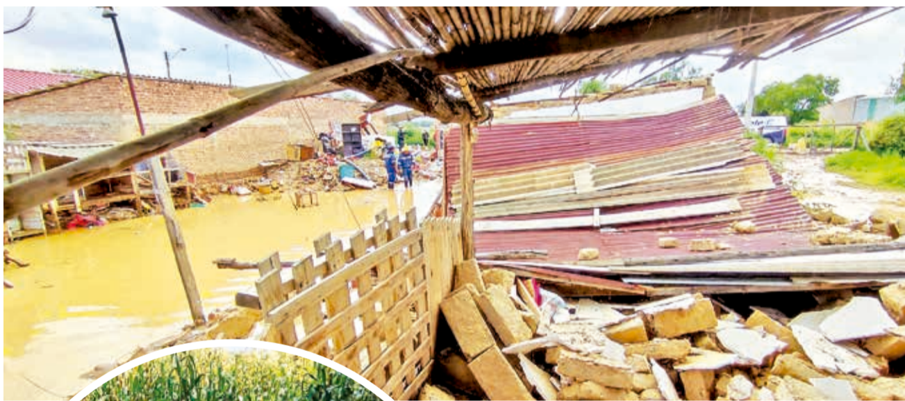
La casa que se derrumbó en la comunidad de Calaminas. DANIEL JAMES
